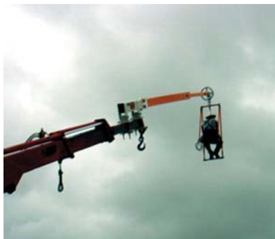
FIGURA 3 – Instalação com Extensão de Grua (1)
